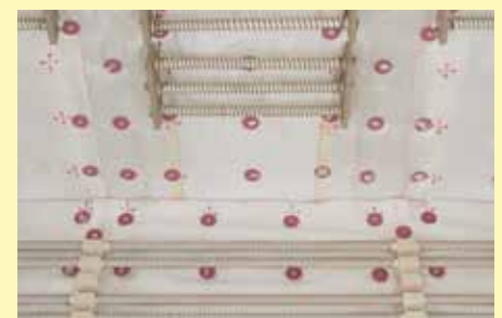
纤维顶面(和侧面)采用织布覆盖, 以减少纤维粉尘
