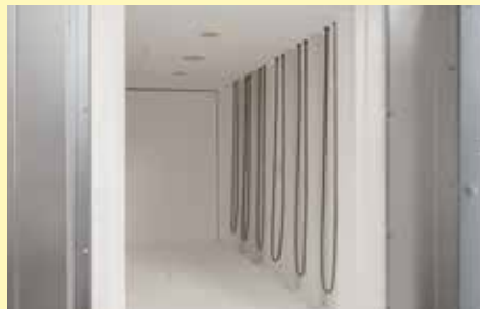
通过穿孔的陶瓷管吹入预加热的新风
