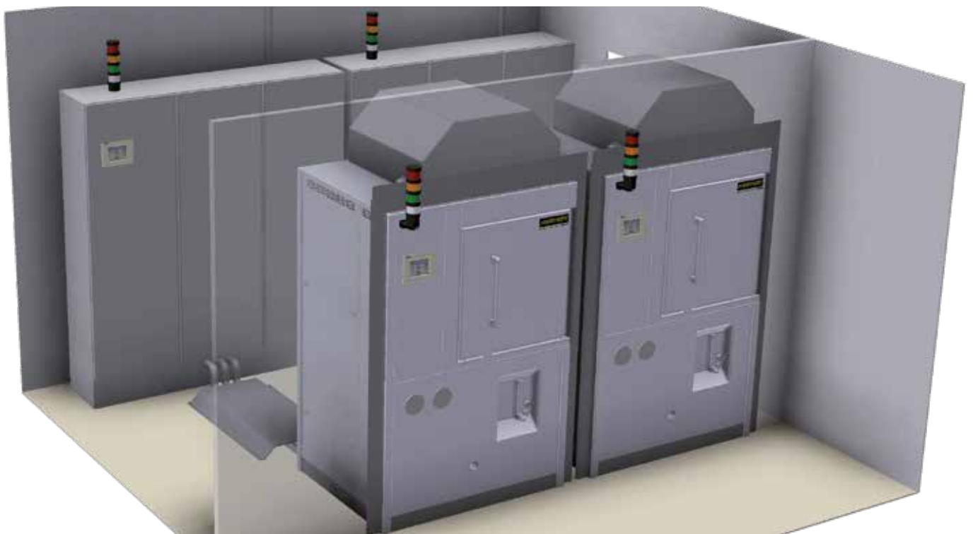
从洁净室装料的高温炉；开关设备和炉体安装在灰室
